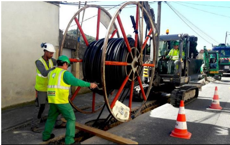
Au service du transport fibre optique partie D1 et D2.
