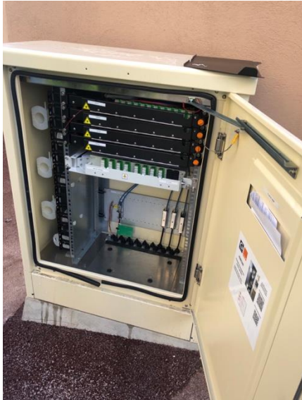
Photo 2 : c'est l'endroit où les câbles de la fibre optique se fixent d'après un outil fourni. La partie noire du câble où se trouve l'étiquette est la partie principale, c'est à dire la gaine d'origine, mais par contre dans la partie bleue il n'y a que la fibre sans la porteuse, kevlar, etc...
